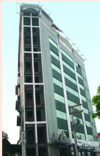
Fachada do Centro Empresarial
