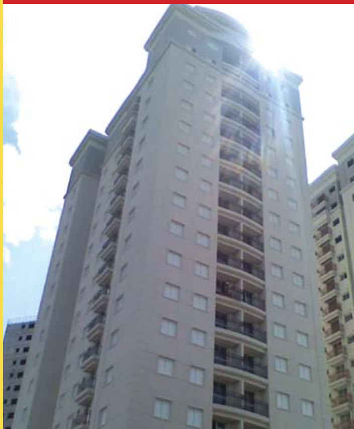
Edifício Gaudi, do condomínio Spazio Dell Arte, em Santo André: técnicas diferenciadas valorizam o empreendimento
