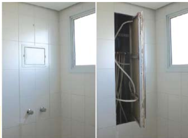
Shaft visitável na parte hidráulica evita a quebra de paredes
